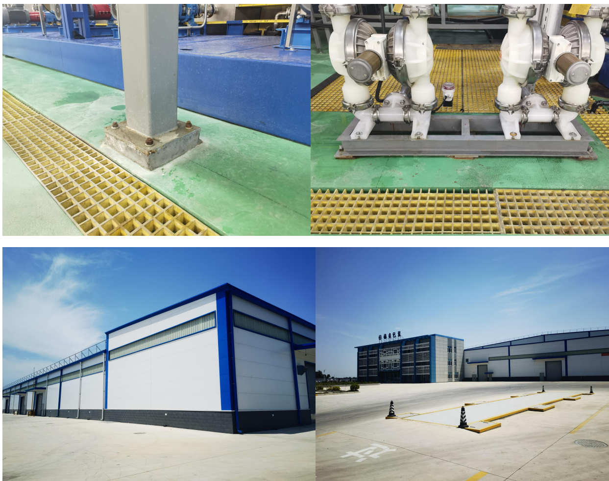
图 3.1-7 设备基础减震及厂房隔声措施
