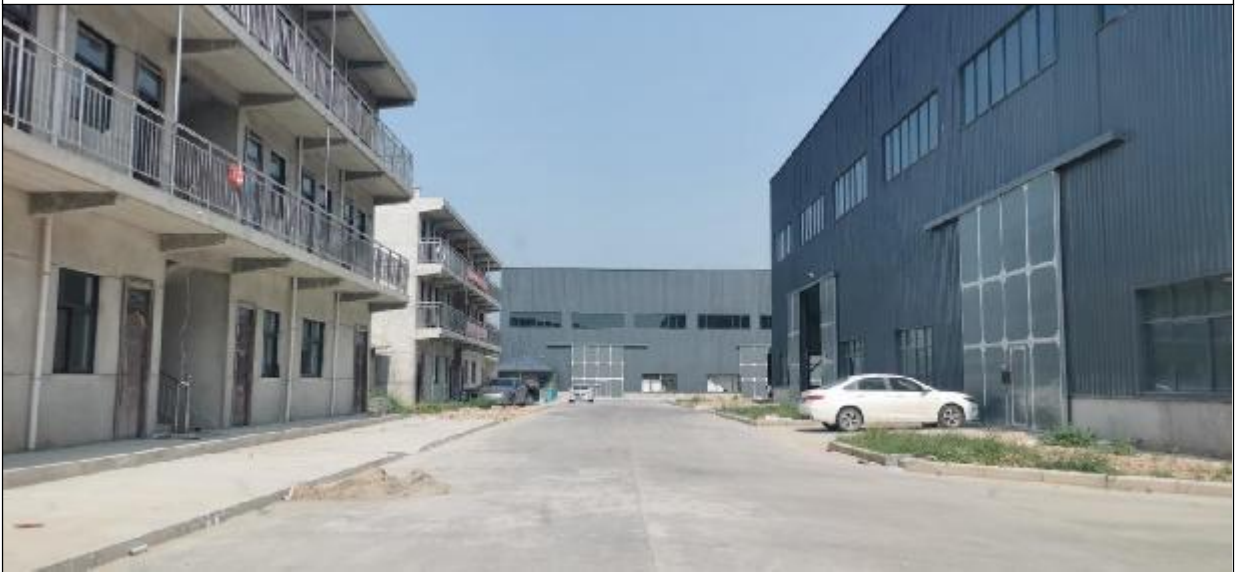
项目道路硬化区
